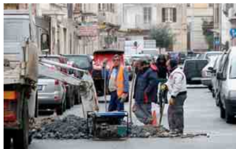
LO SCAVO ALL'INCROCIO TRA VIA BACCHILIDE E VIA IERONE II
