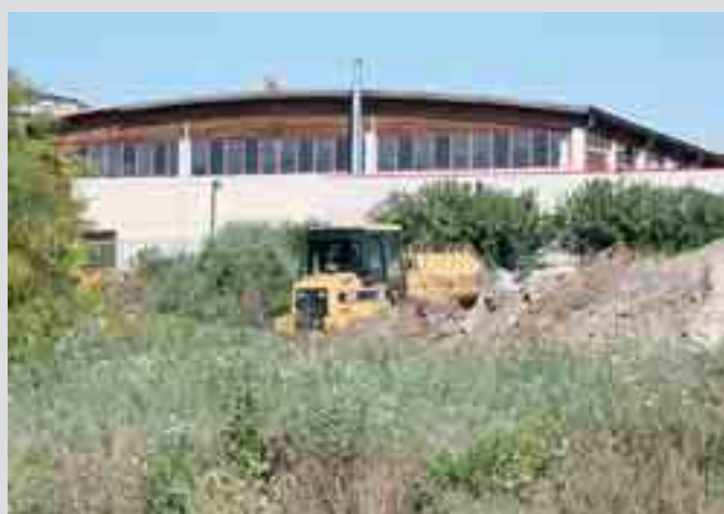
IL CANTIERE DEL PRIMO PALAZZO IN COSTRUZIONE SULLA BALZA
